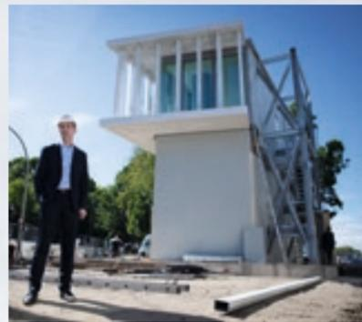
**Hamburg.** Fünf Jahre vor der geplanten Fertigstellung des Elbtowers in der Hamburger Hafencity kann man dort eine Musterfassade des künftig höchsten Gebäudes der Stadt besichtigen. Aufgestellt wurde ein 1:1-Fassadenprototyp – elf Meter hoch, 13,5 Meter breit.
