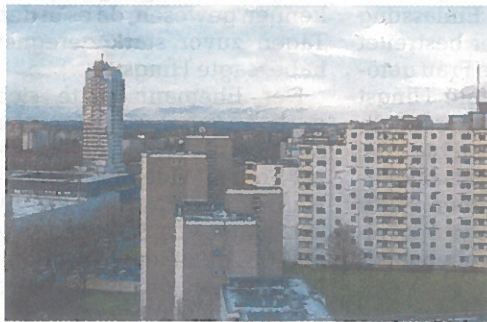
Gebäude, wie hier in Kiel-Mettenhof, zählen ab einer Höhe von mehr als 22 Metern als Hochhaus. Die Angabe bezieht sich auf die Fußbodenoberkante der obersten Etage.
