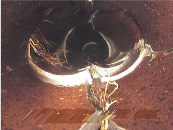
Bild 2: Durchbruch in einer undichten Abwasserleitung.
