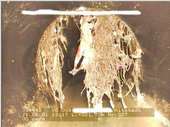
Bild 3: Wurzeleinwuchs in undichte Rohrverbindung.
