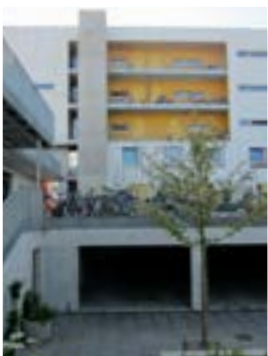
Foto: EM Blick auf die Loggien / Tiefgarage
