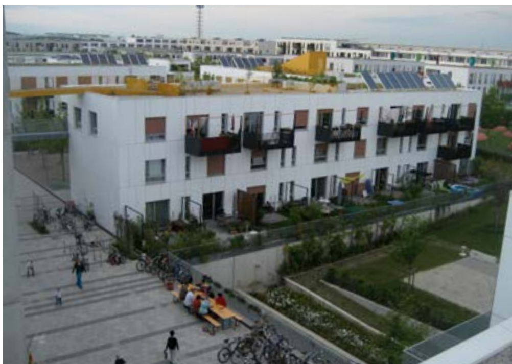
Fot Blick auf die 3-5 geschossigen Zeilen im Innenbereich
