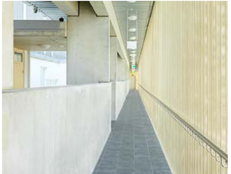
Erschließungsgang (Laubengang) Eigentumswohnungen
