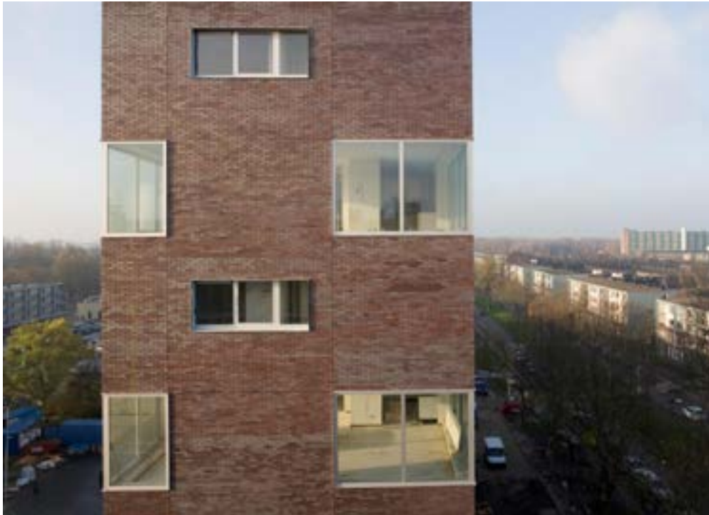
8,70 m schlanke Stirnseite der Hochhausscheibe Palladiumflat
