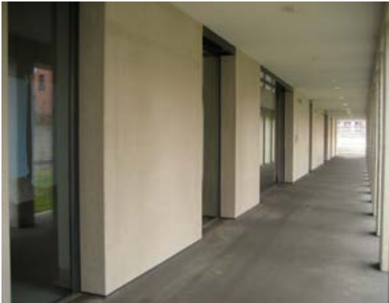
Arkade mit Hauseingang (mittig) und Blick in den Waschraum (links) Foto: EM
