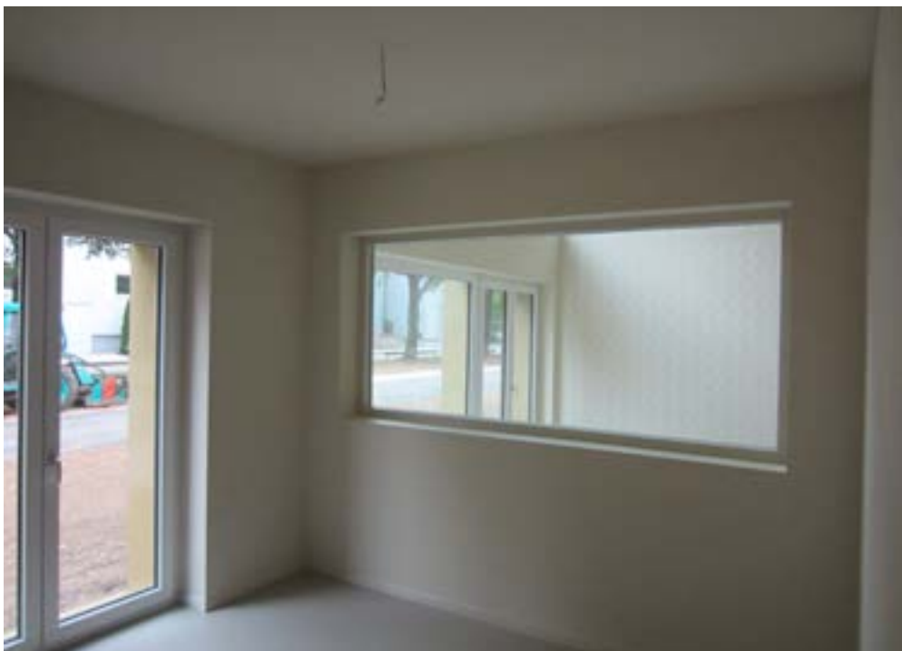
Blick aus einer Küche - während der Ausbauphase - nach außen, direkt und indirekt über die Halle
