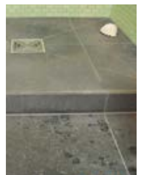
Stufe auf die Dusche Foto: PG
