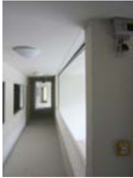
Innengang im 3. OG Foto: EM
