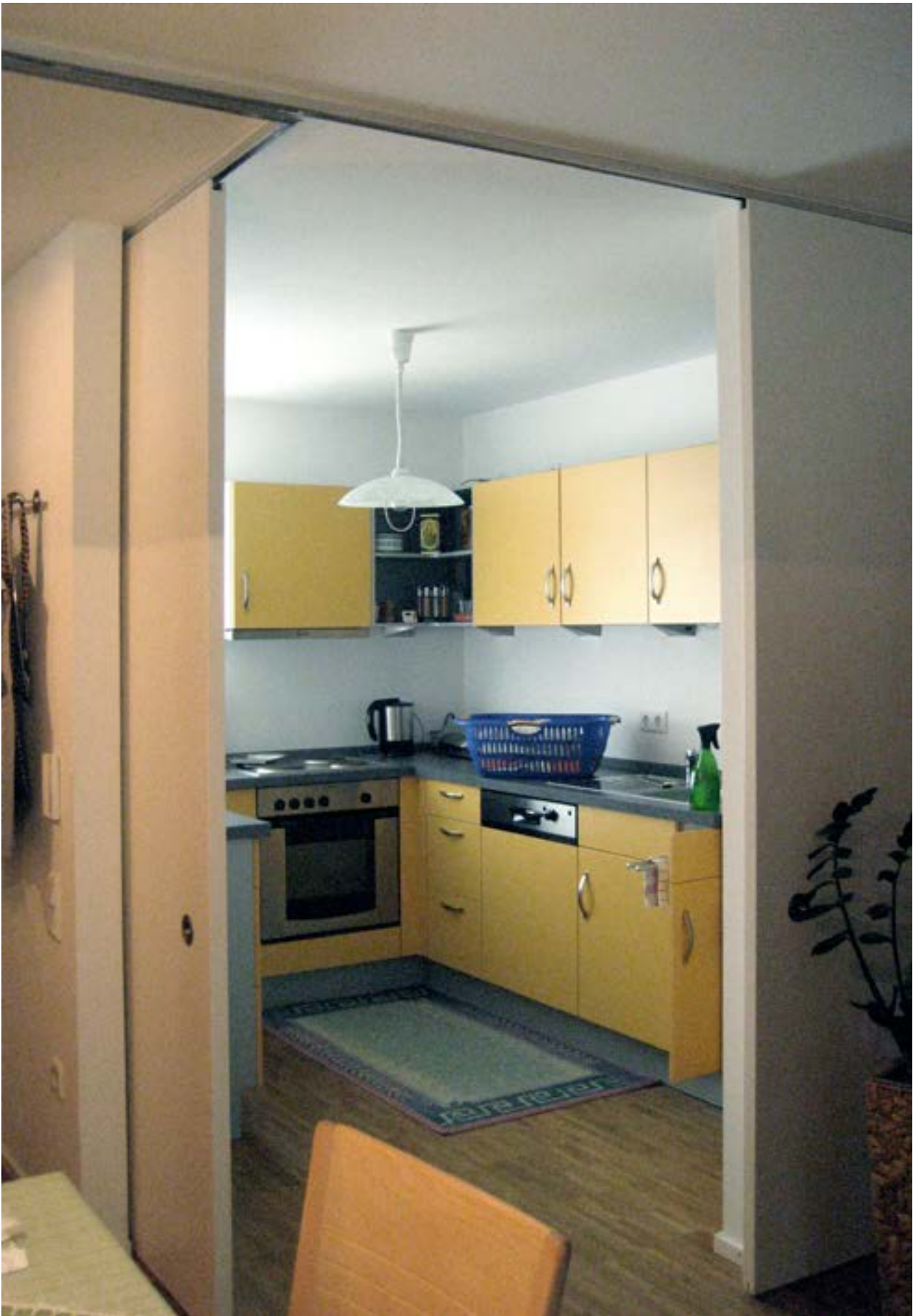
Blick aus dem Wohn-/Essraum in die Küche bei offenen Schiebetüren in der barrierefreien Wohnung (DIN 18025-2)
