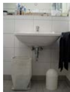
Foto: EM Waschbecken (Ansicht)
