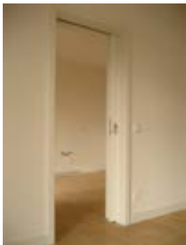
Foto: EM schwellenloser Übergang / Schiebetür
