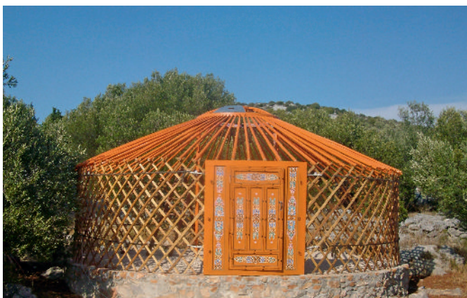
Rohbau einer asiatischen Jurte: Transportabler Holzgerüstbau Foto: Ambroix
