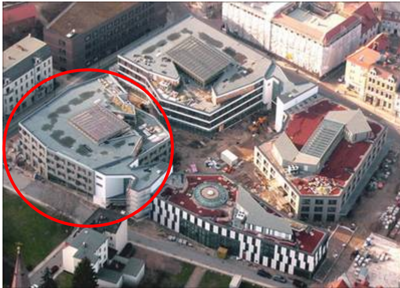
Abbildung 28 Luftaufnahme des DVZ Barnim. Die rote Markierung zeigt Gebäude D, das im Rahmen von ModBen betrachtet wurde.
