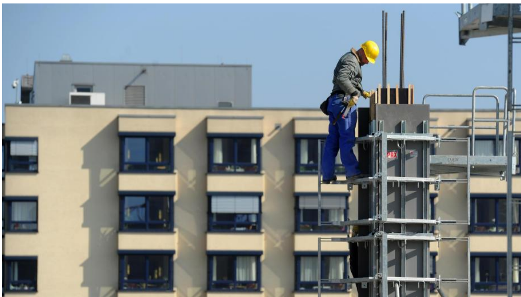
Räume in Serie, hier bei Bauarbeiten in Essen. Foto: AFP
