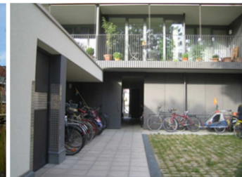
Überdachte Fahrradstellplätze im Hof – München
