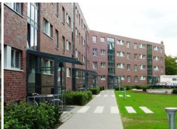
Blickgeschützte, sichere EG-Zonen - Lübeck
