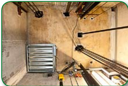
Nachrüstung der Aufzugsschächte mit energiesparendem System.
